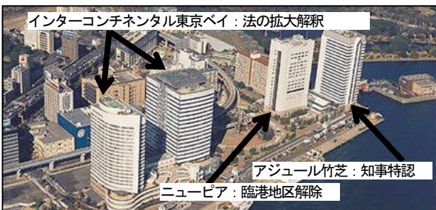
写真-2 竹芝ふ頭の臨港地区における整備 5)
