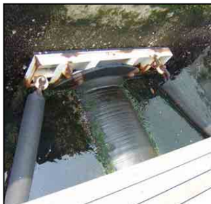
写真 - 2 固定式防舷材(ぶかり)棧橋 写真 - 3 ローラー式防舷材(当事例)
